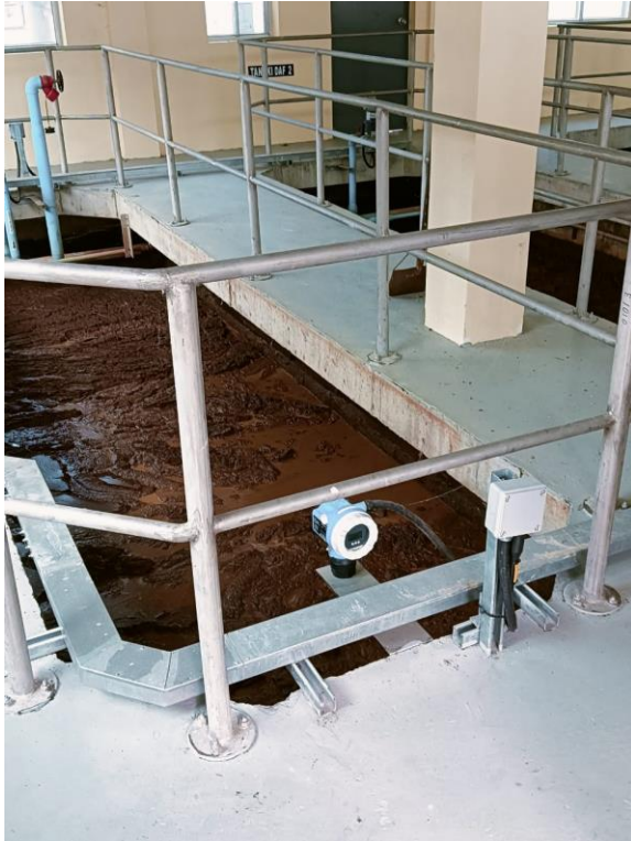
Sistem rawatan air DAF di LRA Gerik VI
