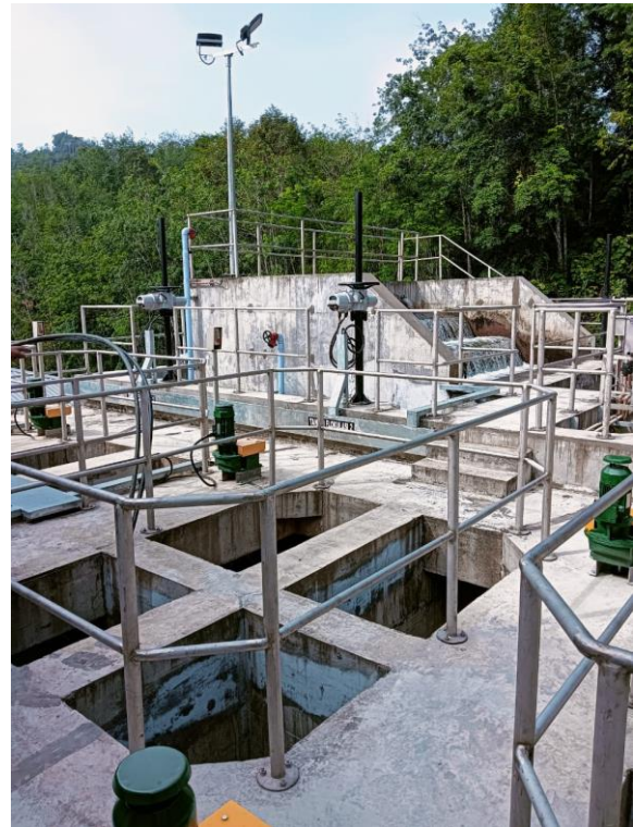
Sistem rawatan air DAF di LRA Gerik VI
