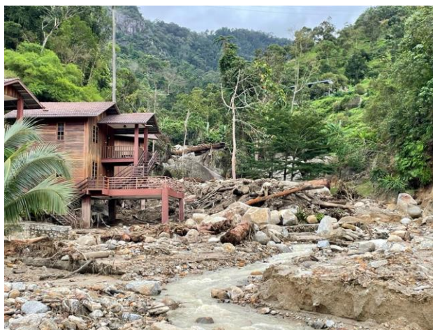
Rajah 6.2 Jumlah bongkah batuan dan puing pelbagai saiz yang banyak boleh memusnah prasarana di sepanjang laluan. Pemetaan terperinci mengenai aliran puing penting untuk merekod zon risiko tinggi bagi mengelakkan bencana yang sama di masa hadapan. Foto kemusnahan di Bobby Eco Resort, Bentong
