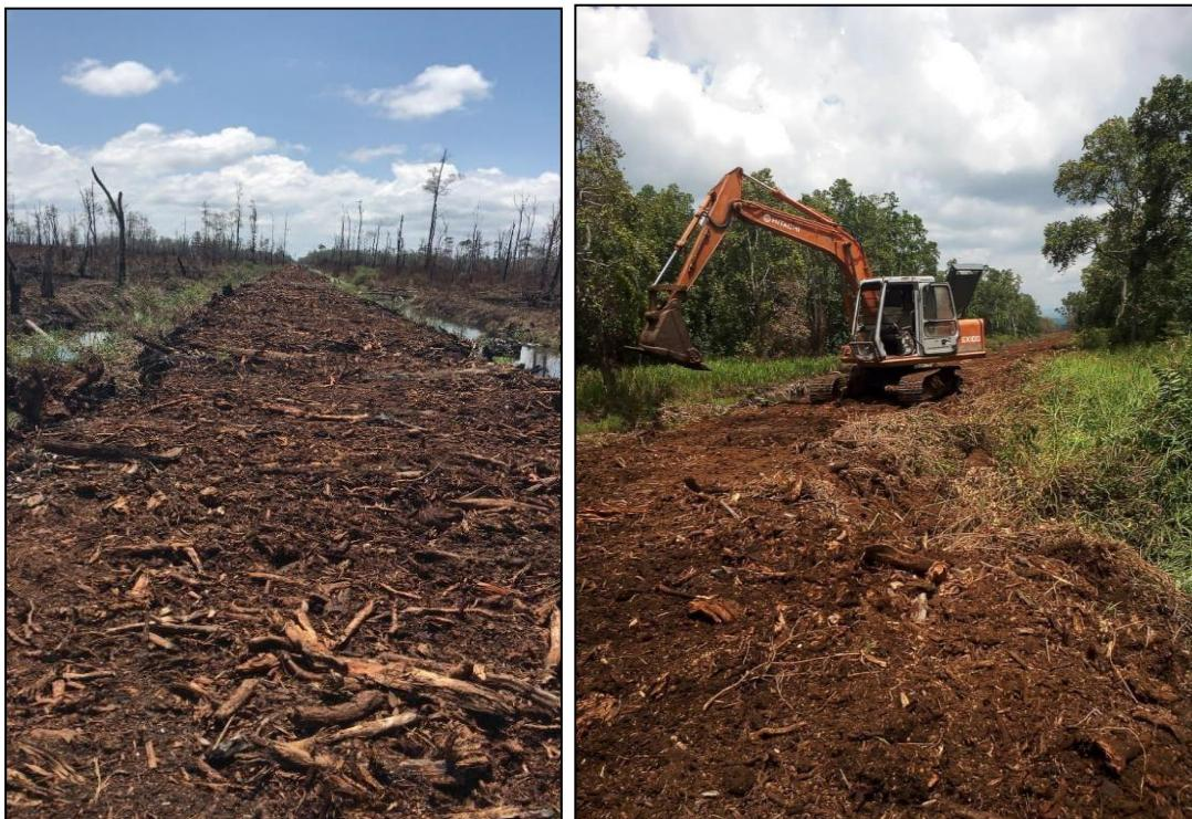
Gambar 28: Pembinaan fire break di hutan tanah gambut
