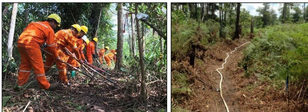
Gambar 33: Pembinaan fire guard (kiri) dan turut digunakan untuk laluan hose untuk water delivery (kanan).
