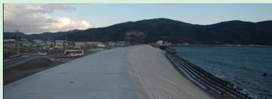
Dinding Pemecah ombak setinggi 10 meter dibina sepanjang pesisiran pantai
